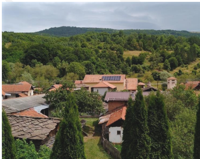
Prikaz ugradnje solarne elektrane na krovu u selu Dojkinci, Srbija
